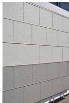
薄型タイル+AL レール工法 （レミュール）
